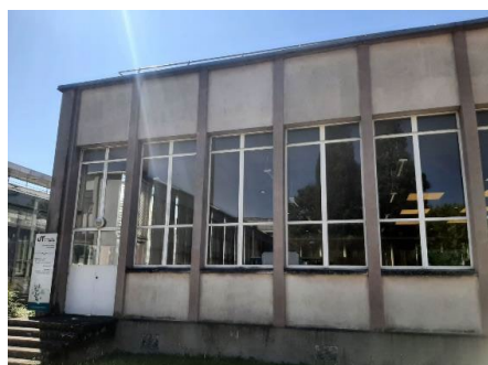
Façade salle de lecture
