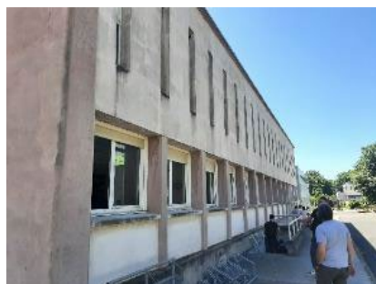
Façade des bureaux
