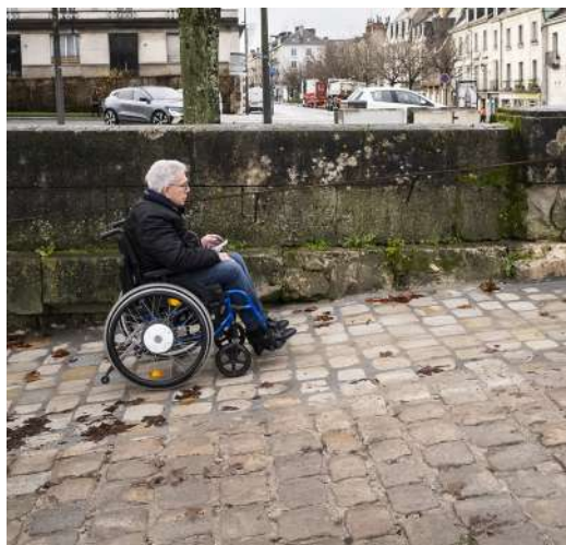
La rampe créée en 2023 pour accéder au quai de Loire (côté guinguette) et faciliter l'accès des PMR.
